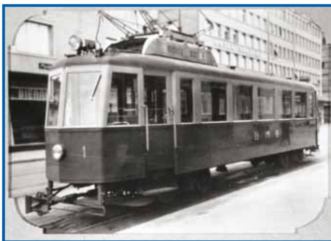
Bahnhofplatz Biel, Triebwagen der Biel - Meinisberg Bahn, Place de la Gare de Bienne, automotrice du chemin de fer Bienne - Meinisberg.
